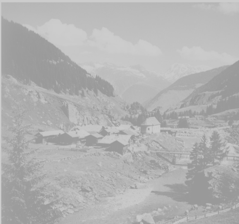
Ein Blick in die Val Medel: Acla vor dem Niedergang der Lawine vom 1975, die den Weiler vollständig zerstörte. (FOTO W. ZELLER/FOTOTECA DRG)
